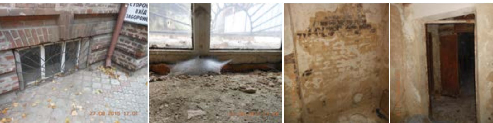
Фото 3-6. Подвальные помещения Славянского городского отдела управления СБУ в Донецкой области.
